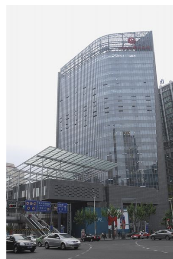
＜複合商業施設「上海湾」外観＞
